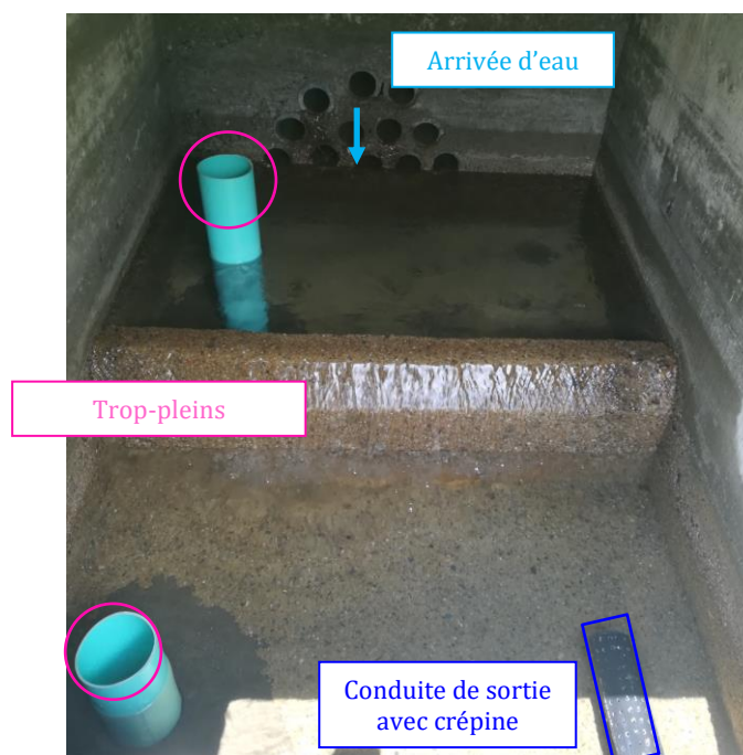
Illustration 19 : Fonctionnement du captage de "Font de Peses 1" (photographie CEREG)
