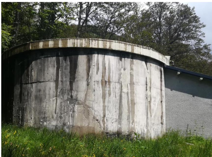
Illustration 5 : Réservoir de la station de ski "Ascou Pailhères" (photographie CEREG, juin 2018)
