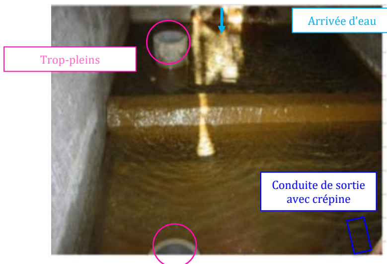
Illustration 21 : Fonctionnement du captage de "Font de Peses 2" (source : SATESE)
